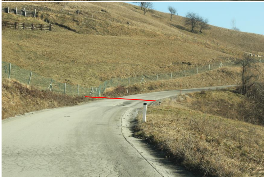
Slika 8 Območje naravnega žleba, kjer je predvidena sidrna pilotna stena
