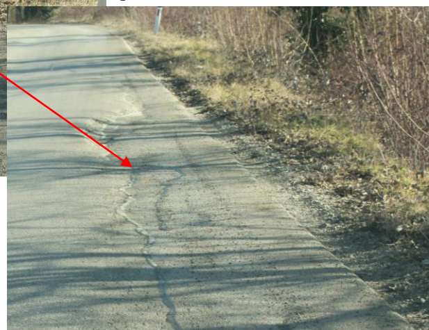
Slika 6 Pogled v območje P16-P19, kjer se vidi vzdolžna razpoka ceste, kar je najverjetneje posledica nasipa v fazi izgradnje ceste. V tem območju je predvidena kamnita peta za raznos prometne obtežbe.
