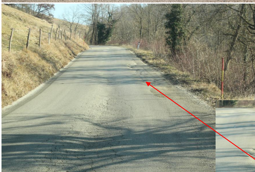
Slika 6 Pogled v območje P16-P19, kjer se vidi vzdolžna razpoka ceste, kar je najverjetneje posledica nasipa v fazi izgradnje ceste. V tem območju je predvidena kamnita peta za raznos prometne obtežbe.
